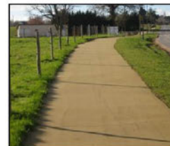
Sablé stabilisé renforcé
