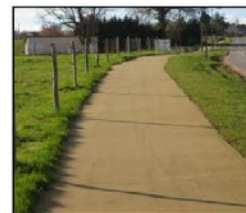
Sablé stabilisé renforcé
