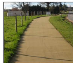
Sablé stabilisé renforcé
